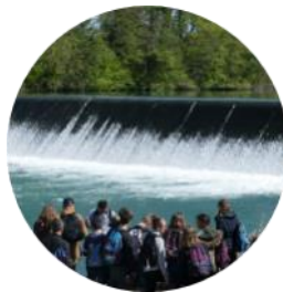
«Espace la Meuse» Site hydroélectrique Gignac
